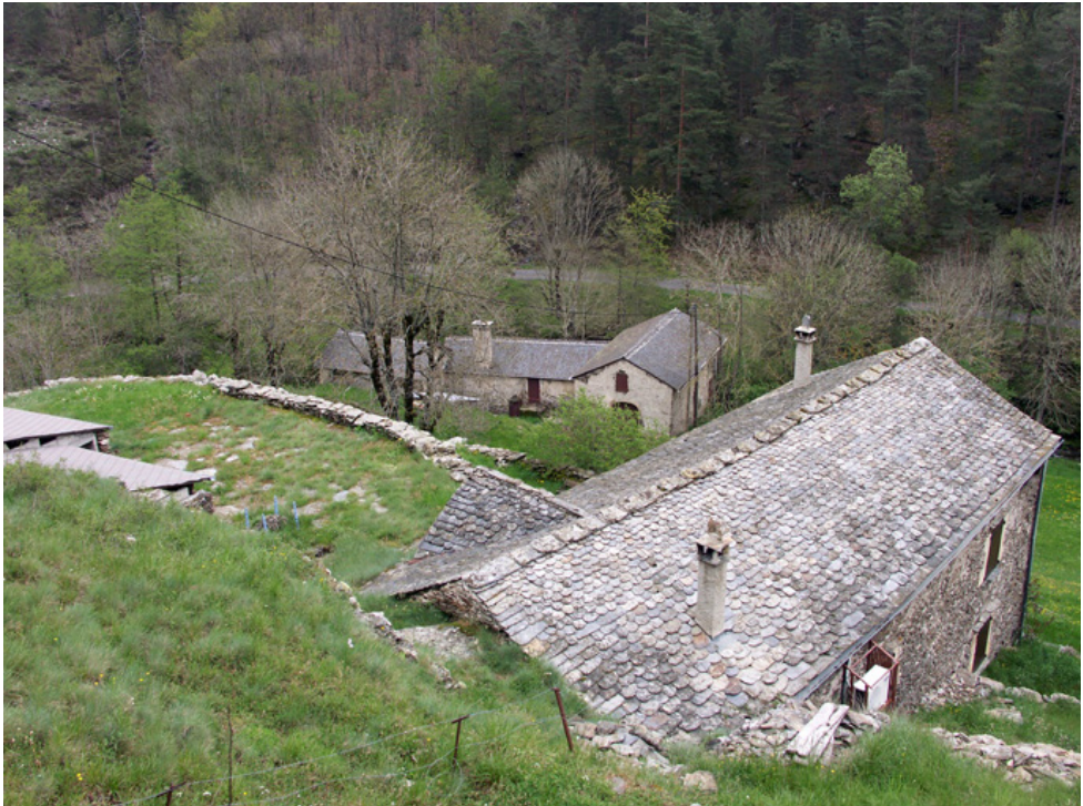
Le moulin de Quet en cours de restauration
