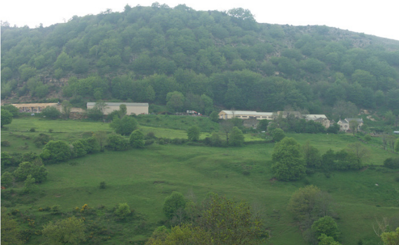
Vue générale sur l'Oultr et ses bâtiments d'exploitation agricole, un mode d'implantation et des coloris qui permettent une l'insertion correcte dans le site
