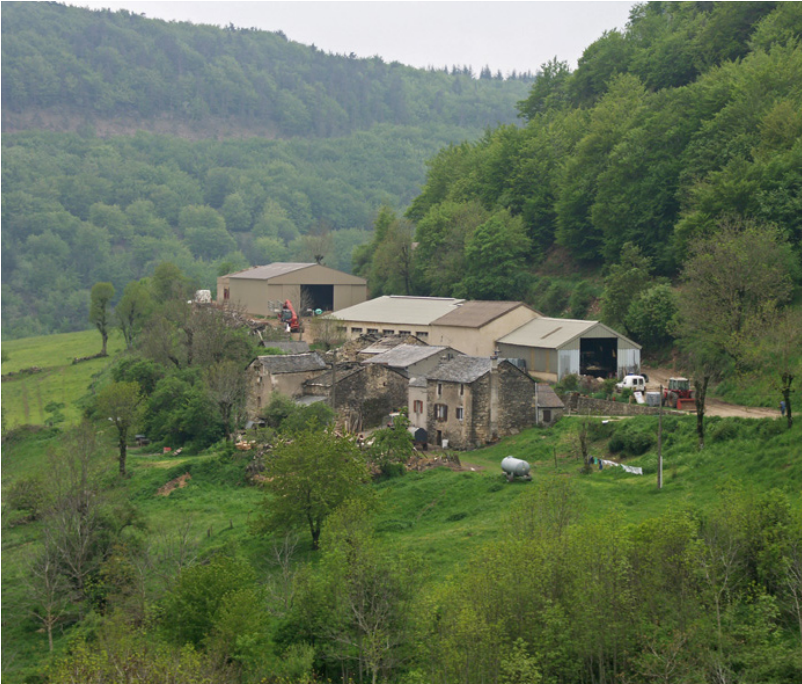
L'Oultr, des bâtiments d'exploitation agricole implantés en continuité du bâti ancien, un rapport d'échelle qui vient totalement détruire les caractéristiques du site bâti initial,
